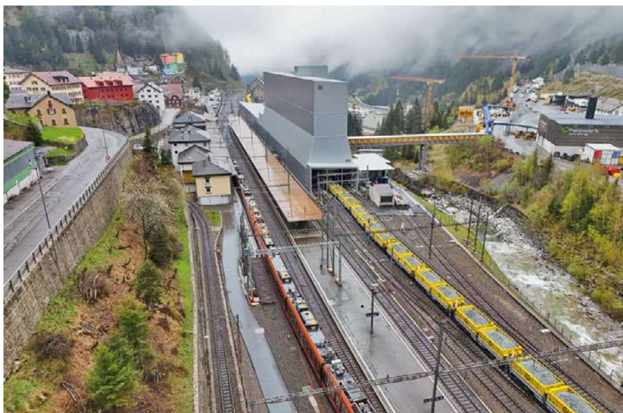
4: In Göschenen entstand, da wo früher der Autoverlad stattfand, eine mächtige Verladeanlage mit Silos über den Gleisen. Links das Gleis der meterspurigen Matterhorn-Gotthard Bahn. In der Mitte ein Treno Gottardo der Schweizerischen Südostbahn. Rechts die Reuss und darüber das Förderband für das Ausbruchmaterial Quelle: Jürg D. Lüthard, Zürich
