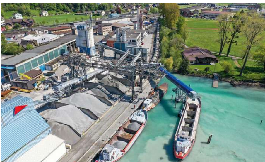
5: Verlad von Bahn auf einen der Schüttnauen in Flüelen
